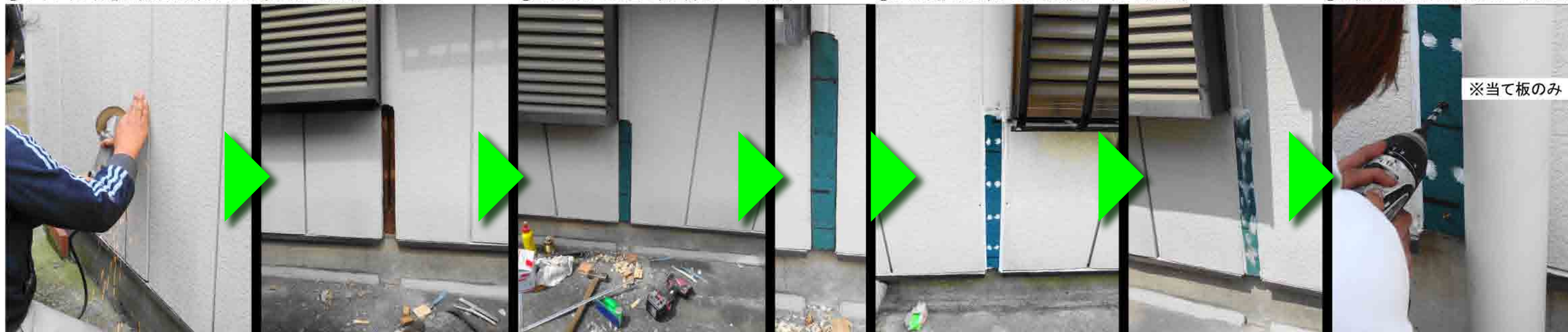
①サイディング材を金物巾より若干小さく柱面まで取り除く。
