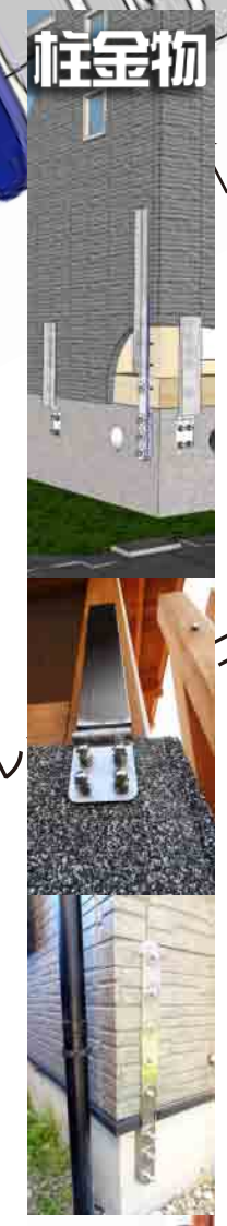
取付前の補強箇所 ▶ 基礎ボルト 頭出部カット ▶ フラット加工後 ▶ フルカバー仕様完成
