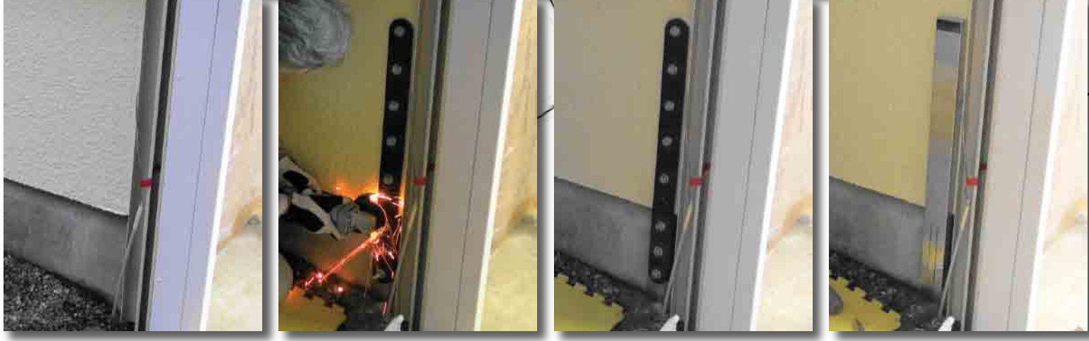
取付前の補強箇所 ▶ 基礎ボルト 頭出部カット ▶ フラット加工後 ▶ フルカバー仕様完成
